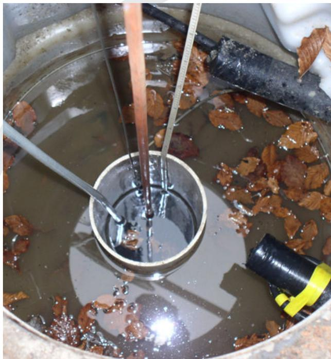
QUICK-LOCK è l'innovativo sistema completamente meccanico per il risanamento parziale interno dei pozzi che, evitando l'utilizzo di colle, laminati o resine di natura chimica, soddisfa tutti i requisiti per il contatto con acqua potabile. Facilissimi da posare, i manicotti QUICK-LOCK possono essere posizionati anche sott'acqua in pozzi dal DN 150 al DN 700.
